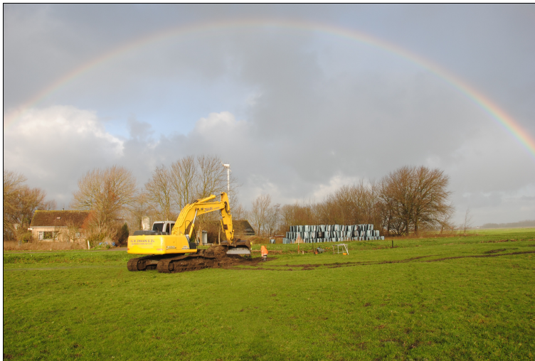
Afbeelding 12. De aanleg van werkput 14. Foto richting noordwesten.
